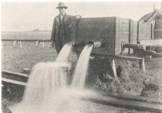
Prøvepumpning ved Marbjerg.
