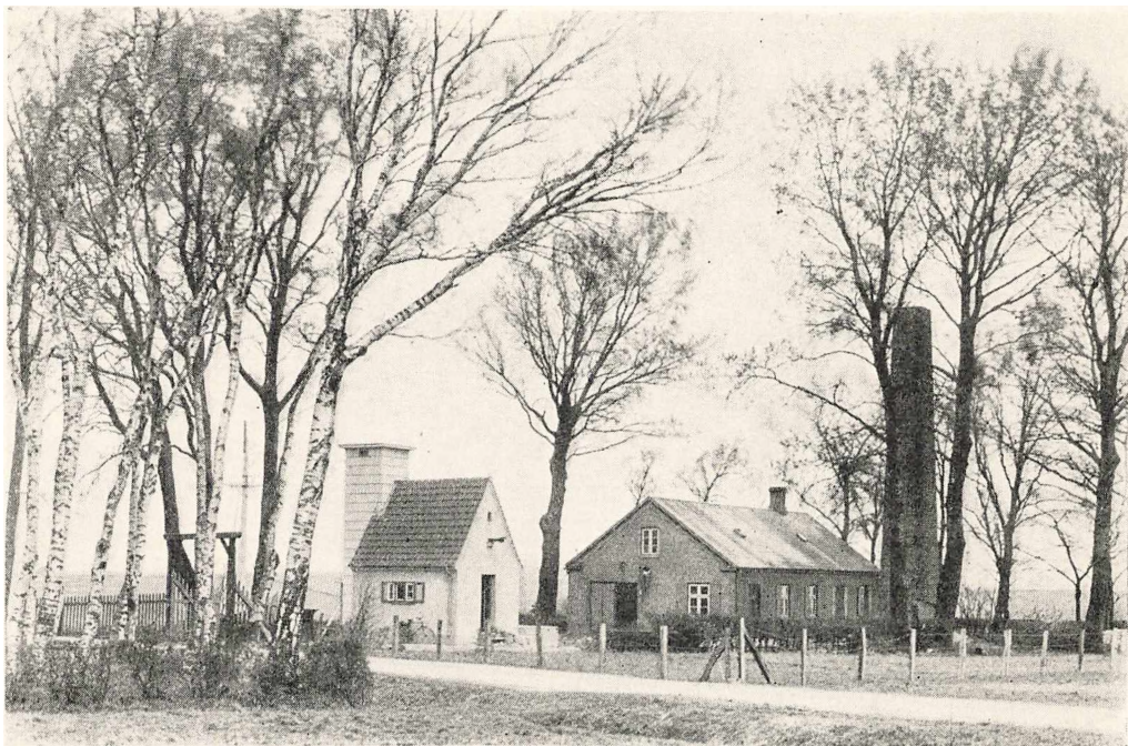
Nyt og gammelt Maskinhus ved Kilde III.
