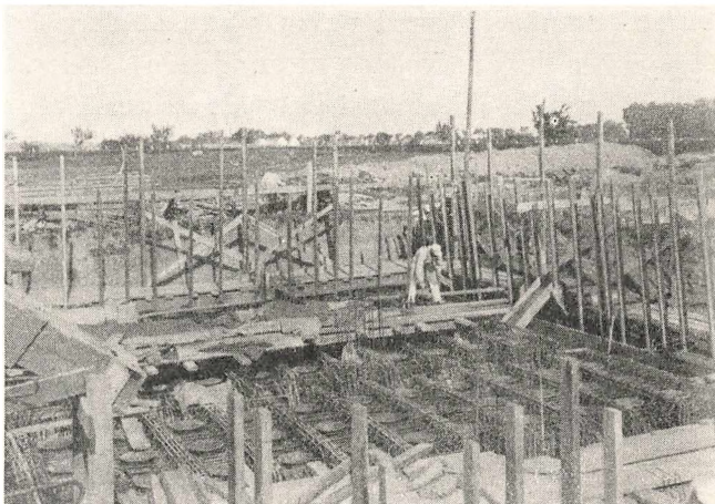
Jernbetonarbejde i Filteranlægget ved Thorsbro.
