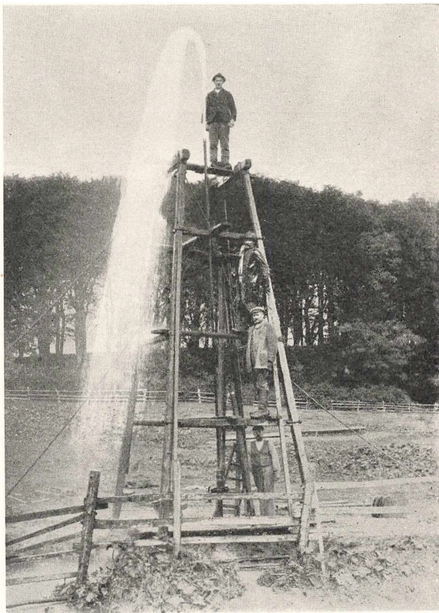
Undersøgelingsboring ved Hule Mølle.
