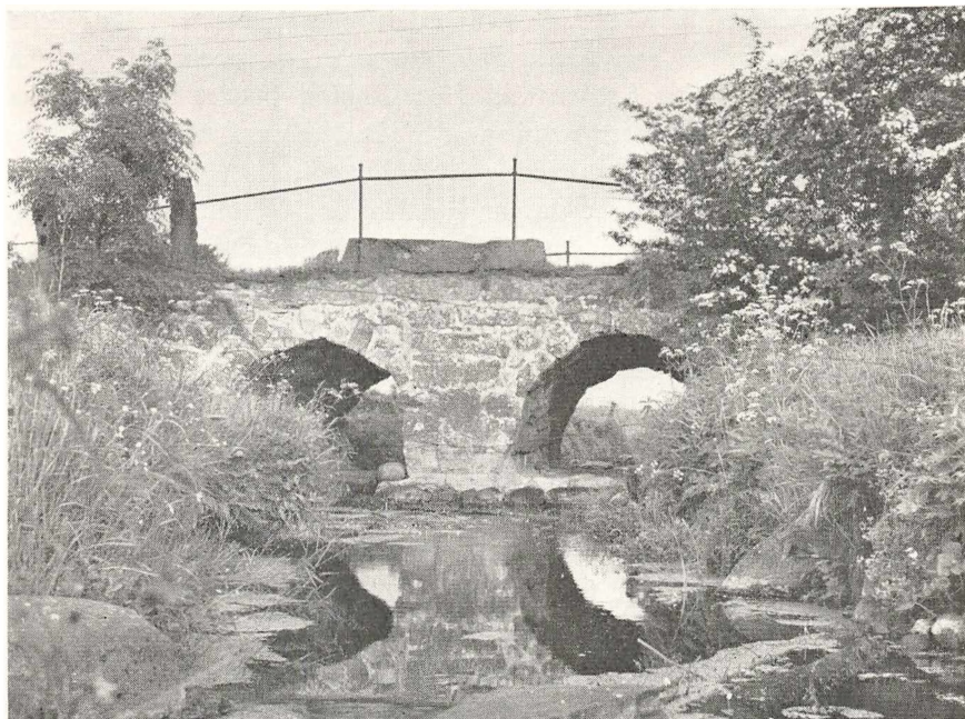
Gejlå bro på Hærvejen nord for Padborg. Hvælvet stenbro med to fag. På en sten anbragt på broen er indhugget årstallet 1779, dette er muligvis opførelsesåret. Fot. : Hans Petersen.
