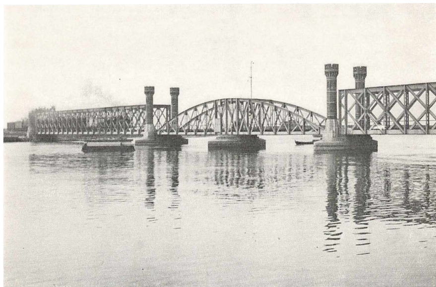
Den første jernbanebro over Masnedsund var en gitterdragerbro med to faste fag og en dobbeltfløjet svingbro. For enderne af de faste fag fandtes 4 par murede nygotiske tårne. Broen blev opført 1883 og nedrevet 1937. Fot.: Elfelt.
