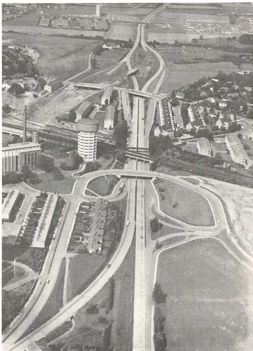
Udfletningsanlæg ved Jægersborg.
