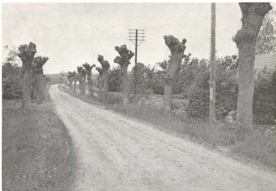
Strækning af den samme vej et hundrede år efter, fotograferet tidligt foraar 1944. De gamle træer er faldet. Der er kommet nye, som er vokset op under vejmyndighedernes kontrol, og som stadig bliver styrede. Fot. : T. Topsøe-Jensen.
