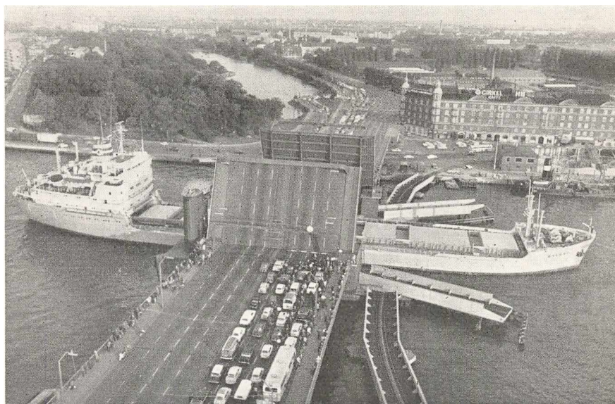
Langebro i København er en dobbelt klapbro. Broen er åben for gennemsejling af et skib på 16.500 t, det hidtil største, der er gået igennem med kun 40 cm vand under kølen. Tilhøjre jernbanebroen til Amager med to enkeltfløjede svingbroer.
