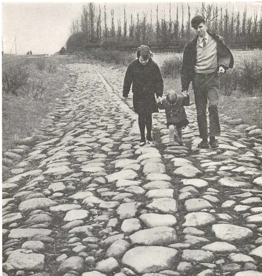
Brolagt vej, sandsynligvis fra middelalderen, ved Helsingø i Nordsjælland. Karakteristisk for disse tidlige vejanlæg er opdelingen i de to vejbaner adskilte ved den midterste stenrække, der i visse tilfælde ligefrem kan være hævet over vejens niveau, saaledes at den danner en regulær adskillelse mellem de to vejbaner.
