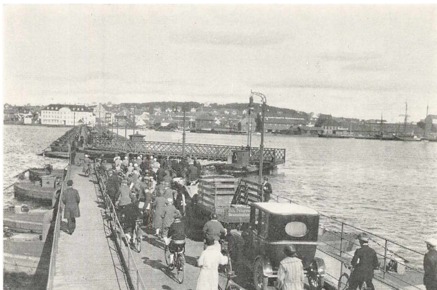
Pontonbroen mellem Ålborg og Nørresundby set fra Ålborgsiden, 1928. Det bevægelige broled er trukket til side, og broen er åben for gennemsejling, mens landtrafikken må vente. Broen er bygget 1865 og fjernet 1933. Fot.: Nørregades Foto.
