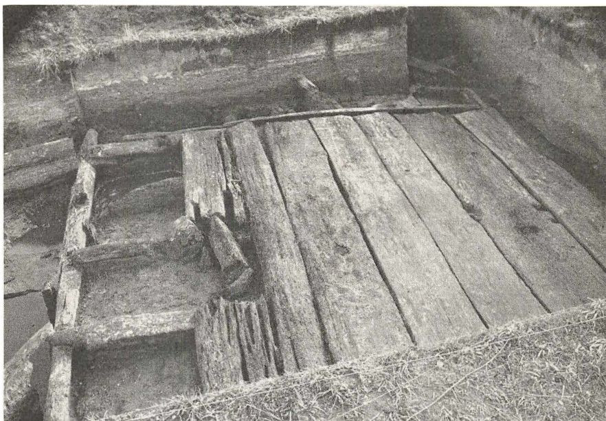
På disse egeplanker har vikingernes tungtlæssede vogne rullet. Plankerne kunne endnu den dag i dag stå for megen kørsel. Detalje af øverste plankevej i Sjellebro. Fot. : T.G.Bibby 1953.
