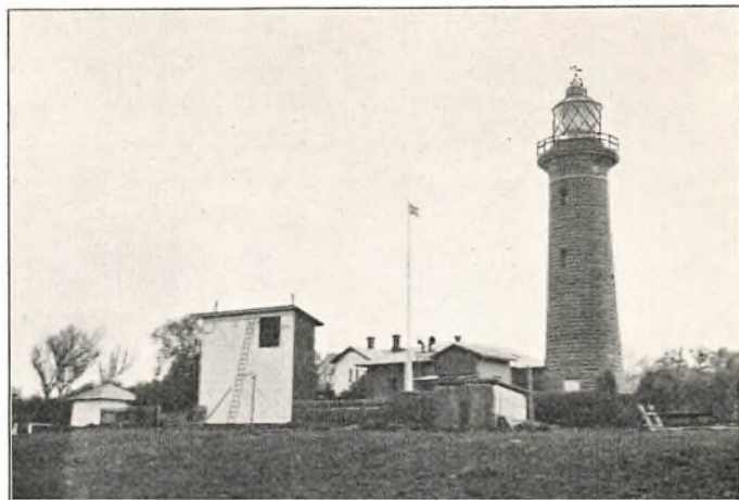
Fornæs Fyr. Til venstre Issignalhuset. Paa den hvide Façade gives ved Hjælp af sorte Trekanter om Dagen og Lanterner om Natten Signaler for Is i Farvandene samt Fyrskibes og Lystønders Fraværelse fra Station.
