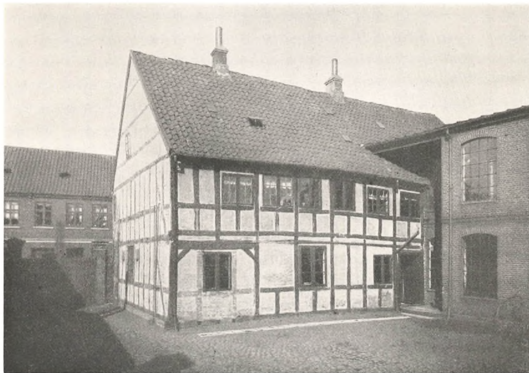
BAGSIDEN AF C. M. HESS' HUS I GRØNNEGADE 1893
