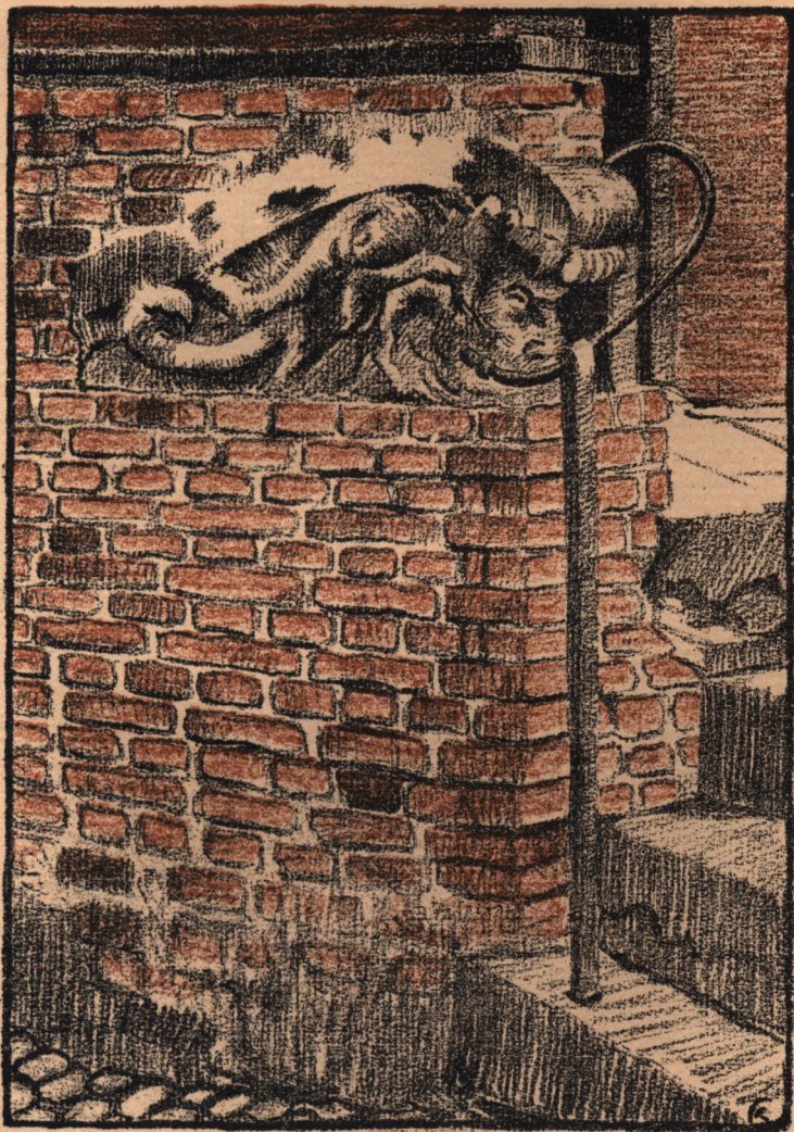
KRONBORG TRAPPEPARTI FRA VAGTEN VED FLAGBATTERIET
