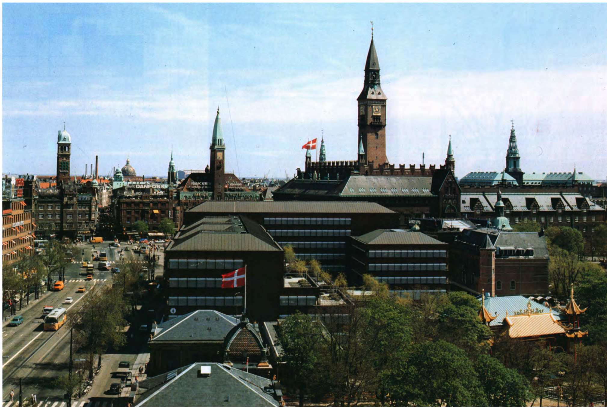
Industriens Hus, set fra Panoptikonbygningen
