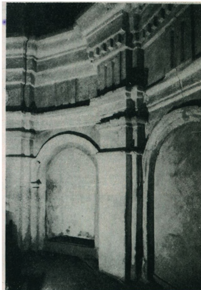
Il. 12. Kościół pobernardyński w Żłoczewie, belkowanie ponad chórem muzycznym z zamurowanymi otworami: na pierwszym planie — wejściowymi do pomieszczenia nad kruchtą, na drugim planie — okiennym o pierwotnym wykroju głifu. (Fot. K. Kowalska)
