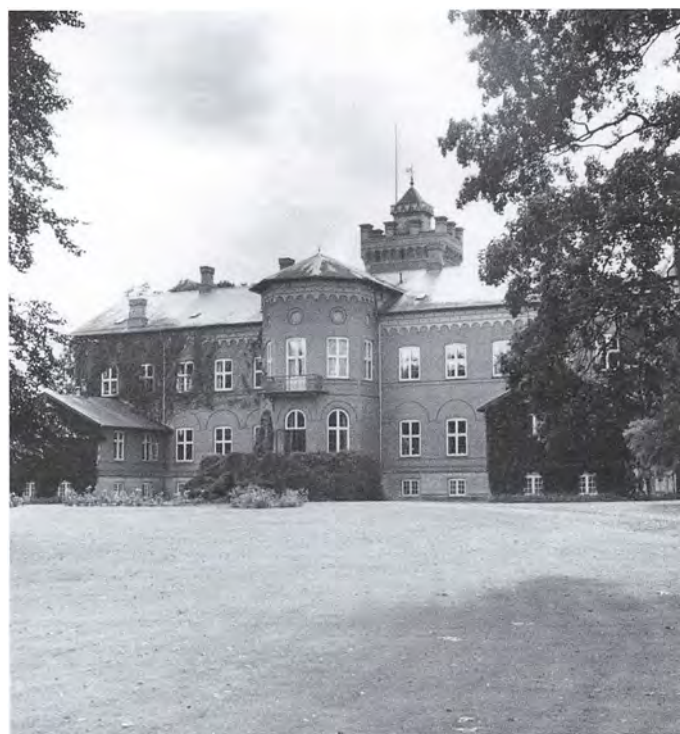
Gyldenholms hovedbygninger set fra haven.
