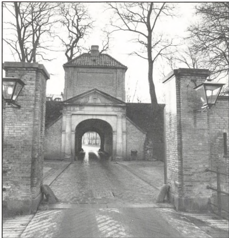
Kastellet i København hvor afhøringer og domfældelse over tømrersvendene fandt sted. (Foto: Harry Nielsen).
