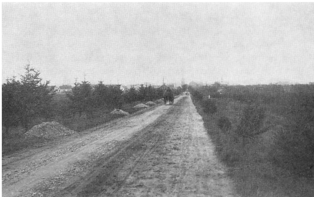
Landevej syd for Herning i en lidt senere periode. Man lægger mærke til vejreparationen og de mange grusdynger.
