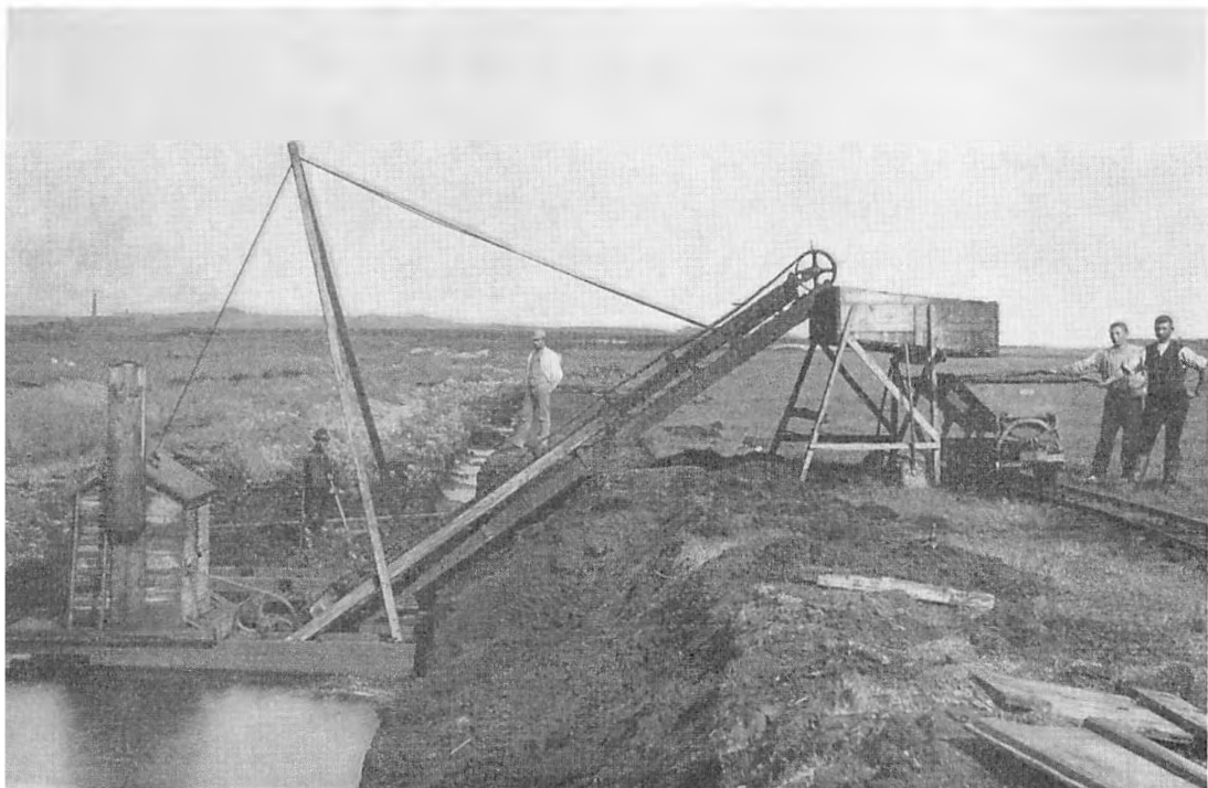
M. Rahbeks flydende tørreværk i Økær mose, Sparkær. Ved at anbringe kraftmaskine, ælteværk og elevator på en pram opnåede Rahbek, at tørreværket også kunne anvendes, hvor råttørven for en stor del skulle optages under vandspejlet.
