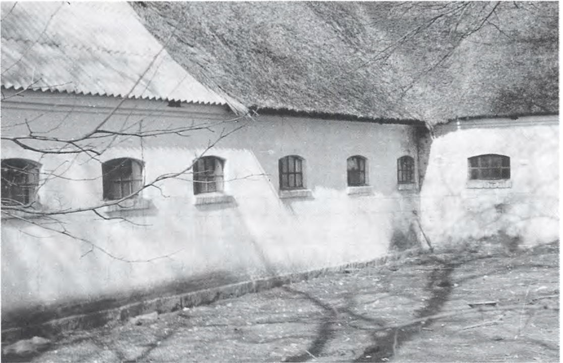
Ældre ladebygninger blev fra 1950'erne ombygget til den lønsomme svineproduktion. Eternittage og massefremstillede staldvinduer afløste de gamle stråtage og de sprækker i murene, som i gamle dage gjorde det ud for vinduer.
