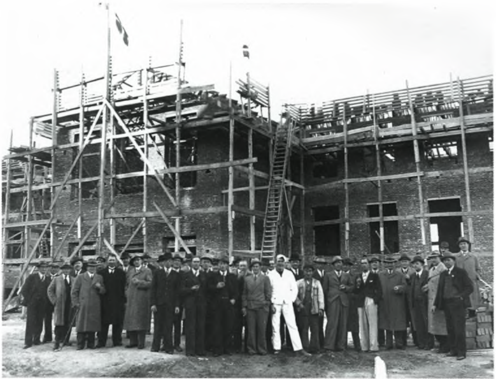
Den 26. september 1938 afholdtes der rejsegilde for Bygning C.
