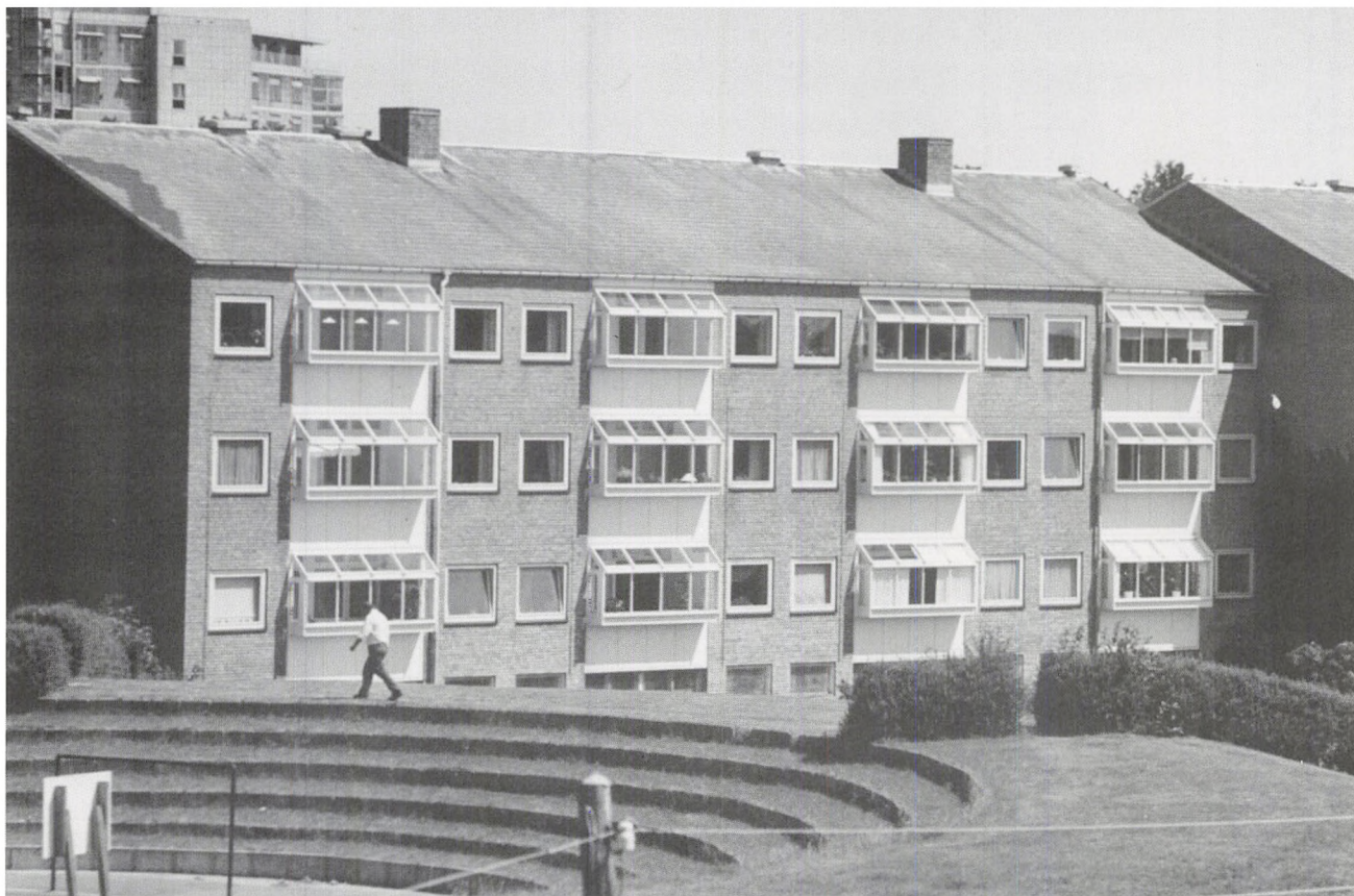
I Stadionkvarteret er der i forbindelse med nogle påkrævede betonrenoveringer i årene 1991-93 skabt nogle nydelige karnapper ved »at inddække altanerne«, som det hedder i fagsproget - en foranstaltning, der videreføres i de kommende år. Dette billede er fra Hegnet. Den runde legeplads ses foran bygningen. Foto 1993.
